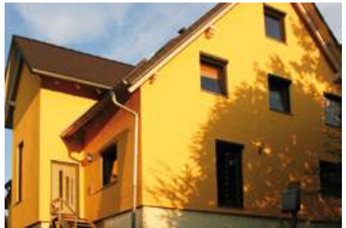
Façade après isolation et application de l'enduit
