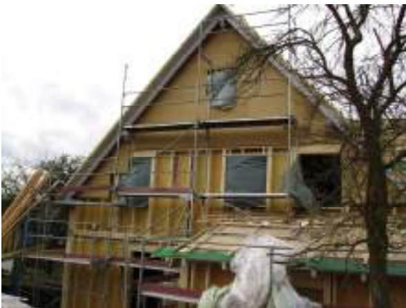
Nouvelle construction à ossature bois
